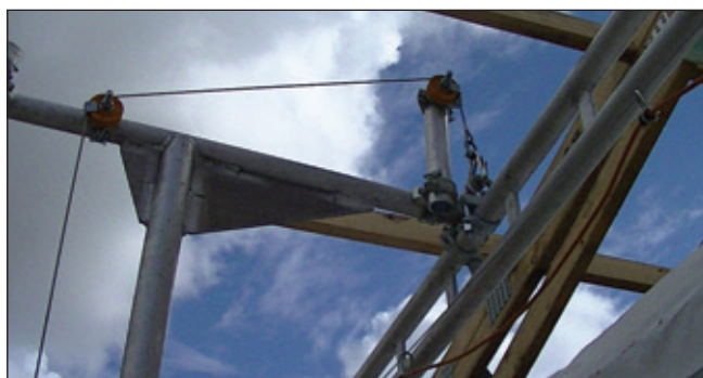
Fig. 4.3 – Hebel hoist
